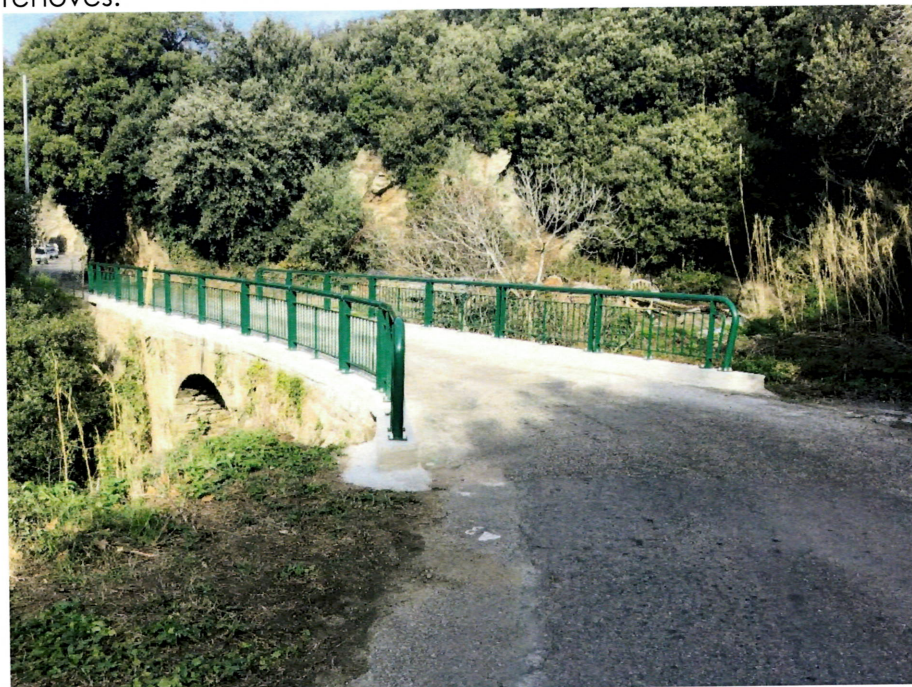
Photo 19 : les gardes-corps du pont "d'Anton-Marcu" rénovés
