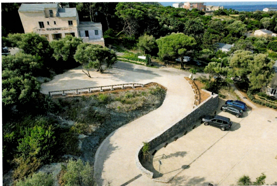
Photo 16 : vue aérienne du nouveau parking
