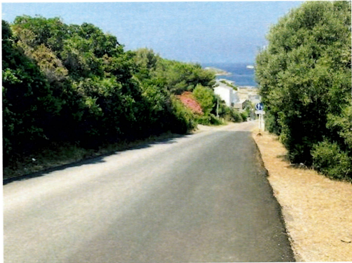
Photos 13 et 14: une voirie rénovée au Port
