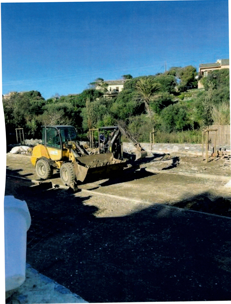
Photo 9 : Travaux d'aménagement du parking di a Caraja
