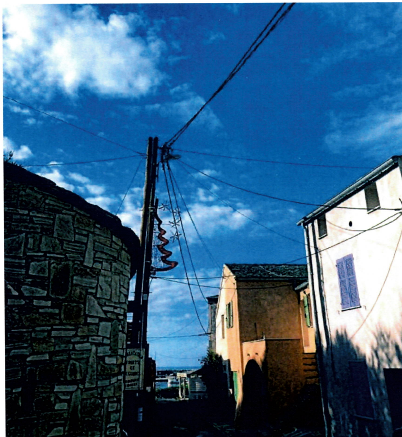
Photo 7 : Lignes aériennes inesthétiques au port
