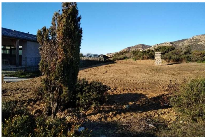
Photo 3 : Plate-forme d'accueil de la future aire de jeux
