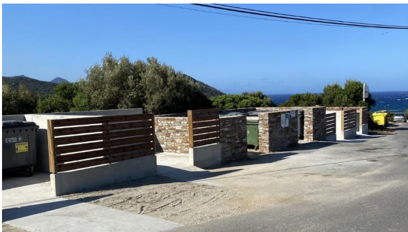
Photo 9 : Réhabilitation du point de collecte d'a Caraja
