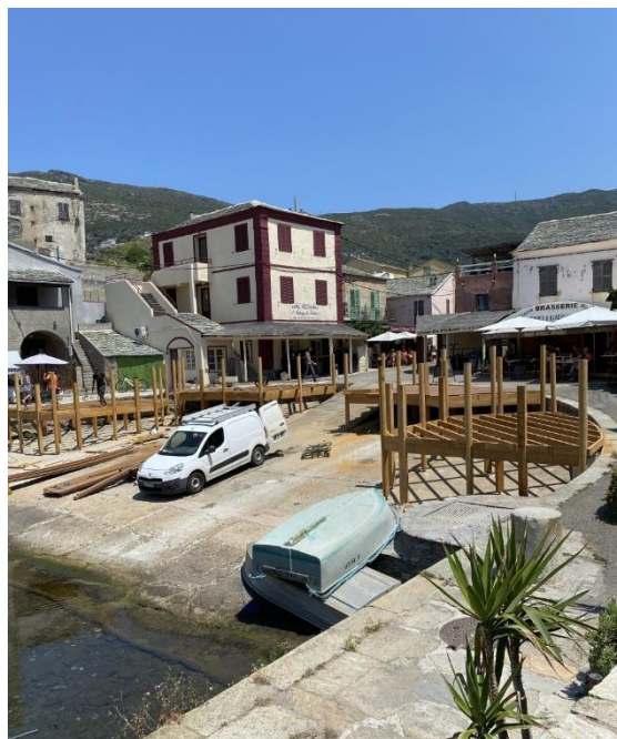
Photo 11 : Les Terrasses en cours de construction
